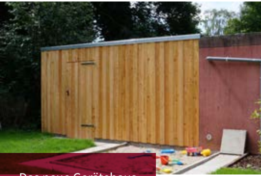
Das neue Gerätehaus
