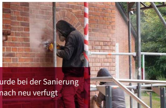
Fuge für Fuge wurde bei der Sanierung entfernt und danach neu verfugt
