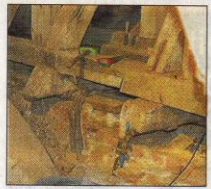
SCHADHAFTEN Balken werden einzeln ausgetauscht.
